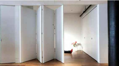
Tabique móvil en acordeón para cierre de despacho.
